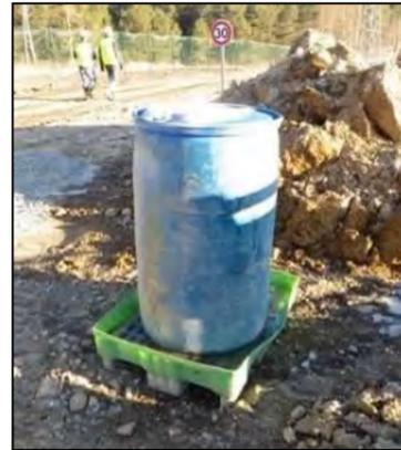
Figure 90 : Stockage d'hydrocarbures dans un bidon étanche sur bac de rétention (Source : Abies, suivi de chantier)
