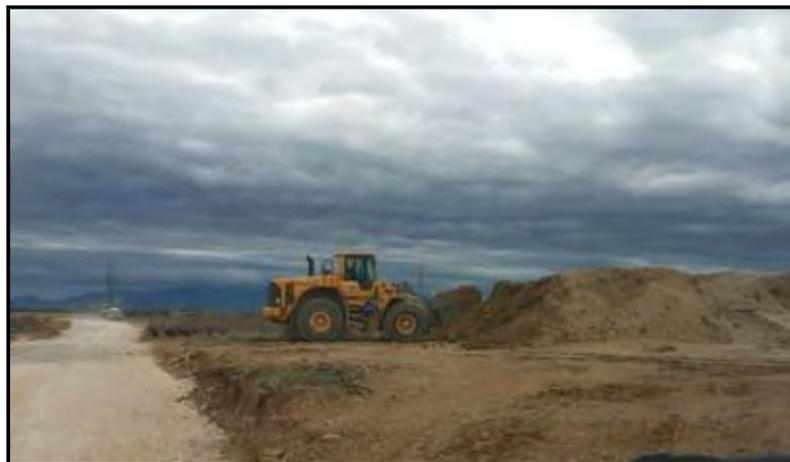
Figure 94 : Reprise de la terre stockée pour le remblayage des fondations (Source : Abies, suivi de chantier éolien)
